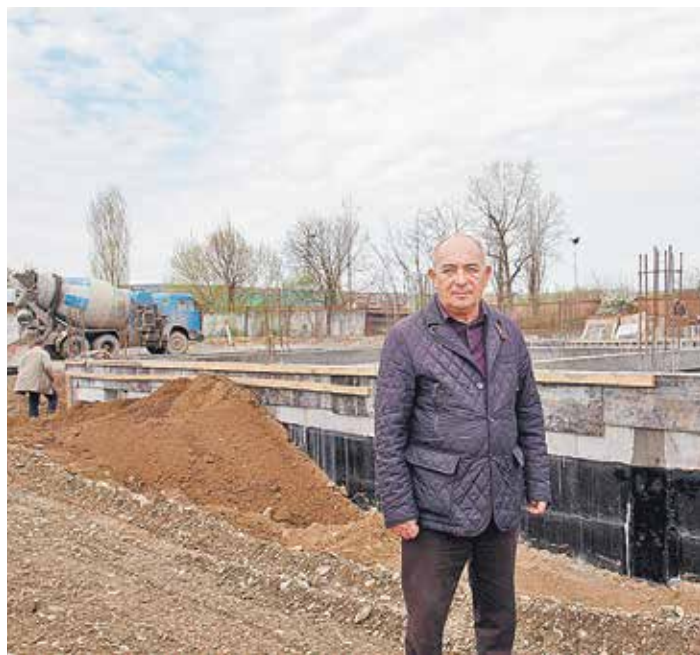
Абдула Такаев на строительной площадке в микрорайоне «Солнечный»
