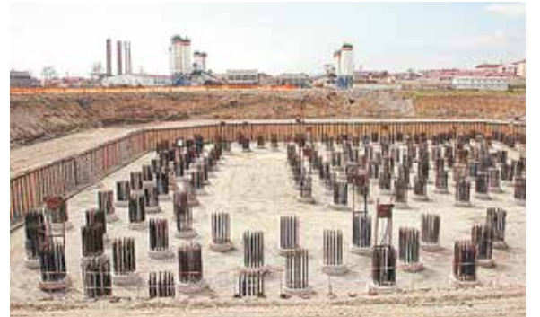
На начальном этапе строительства
