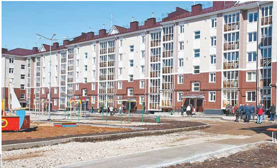
Новый пятиэтажный 155-квартирный дом №28/4 по улице Полющенкова в городе Чистополе Республики Татарстан, где недавно получили ключи переселенцы из аварийного жилья
