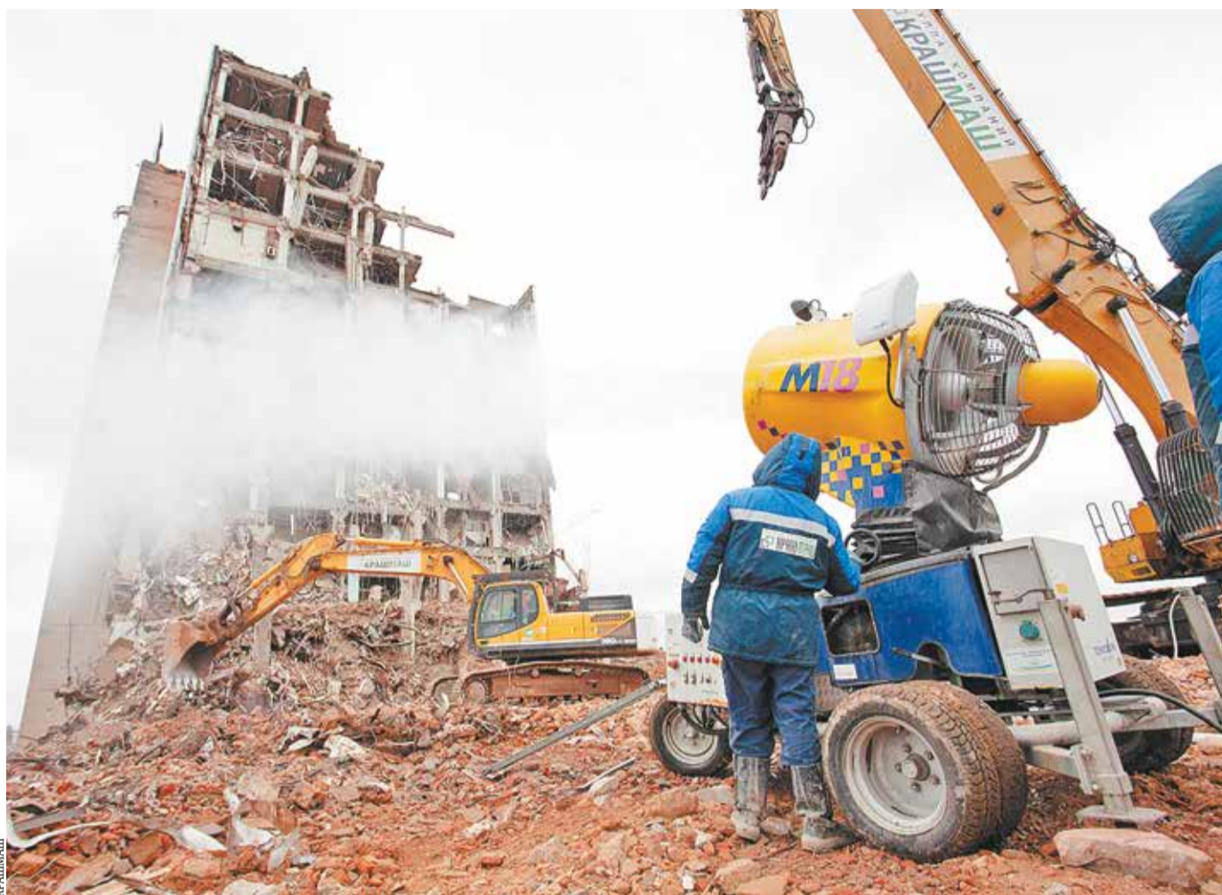
Компания «КрашМаш» в сжатые сроки снесла 70-метровое здание на пересечении Волоколамского шоссе и МКАД
