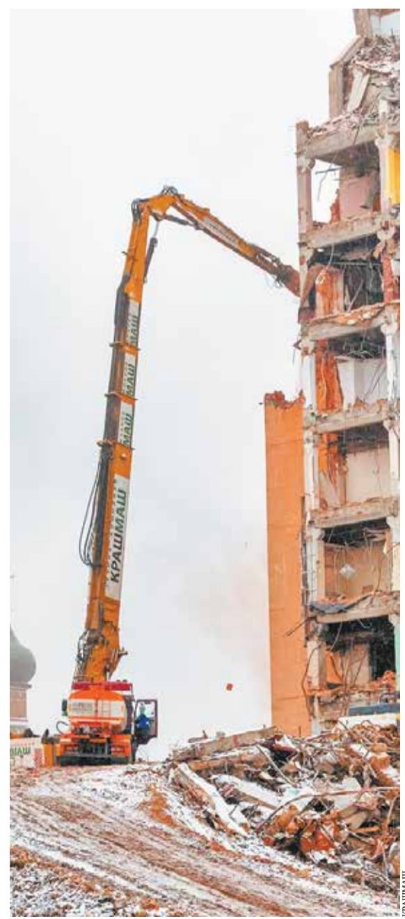
При производстве работ использовался экскаватор CAT-390
