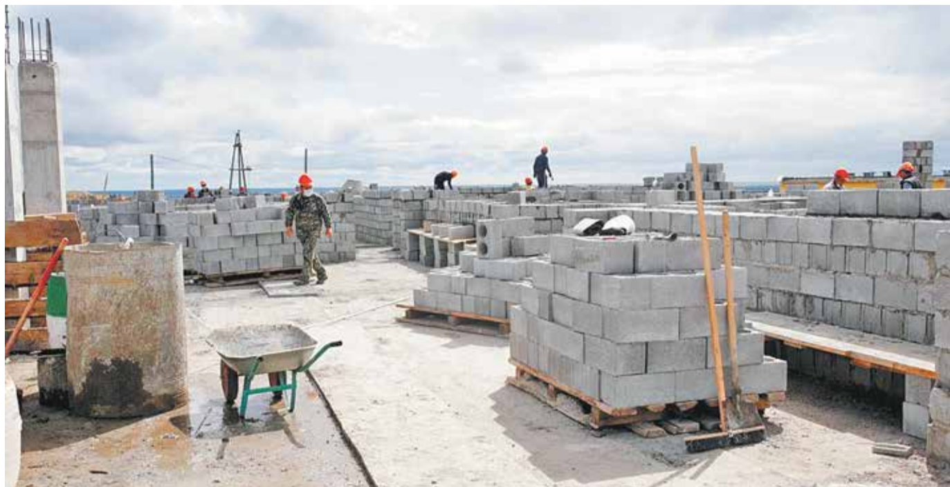
Строительство школы на 360 мест в 203-м микрорайоне Якутска
