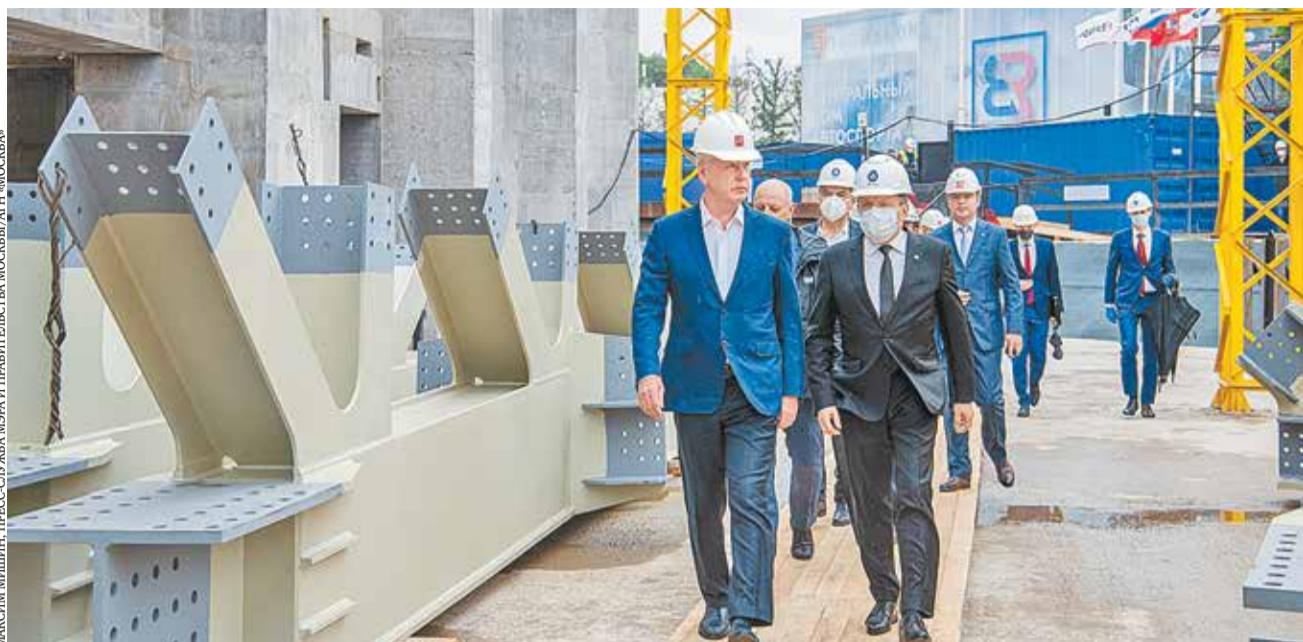
Мэр Москвы Сергей Собянин (слева) и директор ГК «Росатом» Алексей Лихачев на строительстве нового павильона «Атом» на ВДНХ
