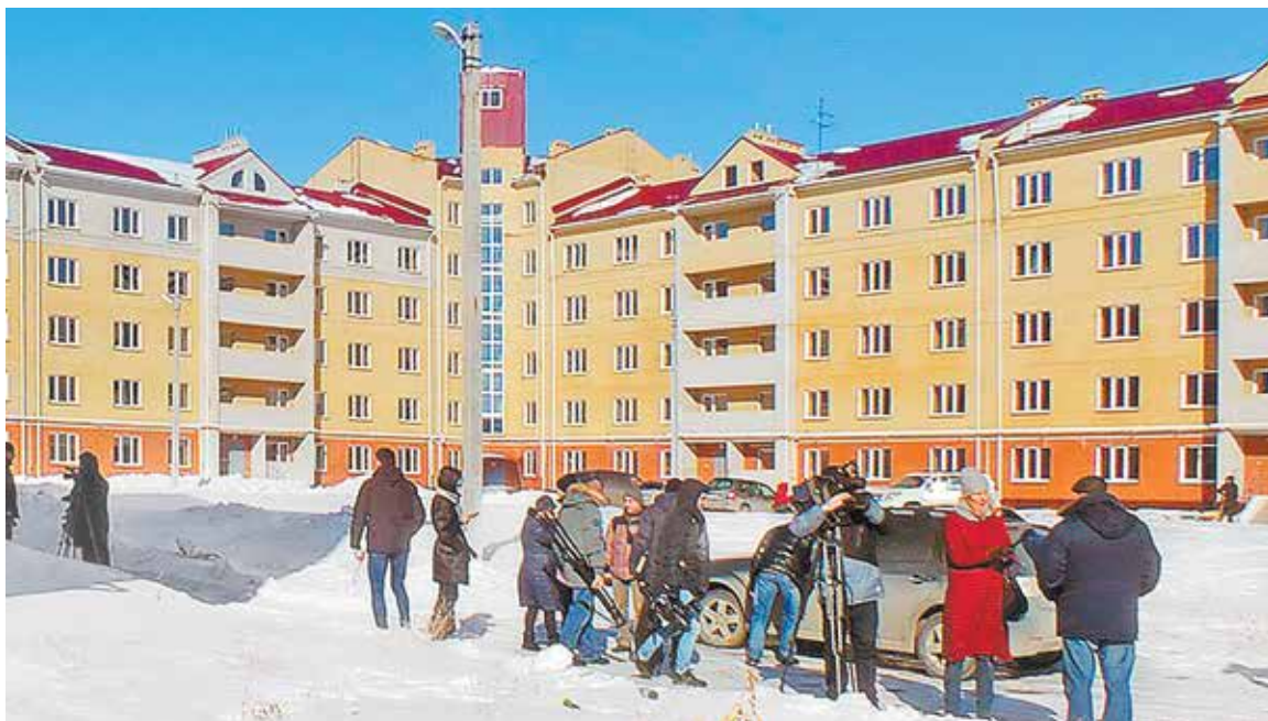
Достроенный дом в микрорайоне «Ясная поляна»
