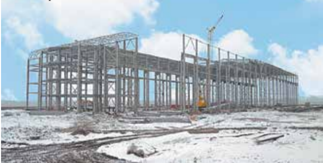
Строительство логистического и складского центра ELKON в г. Самаре
