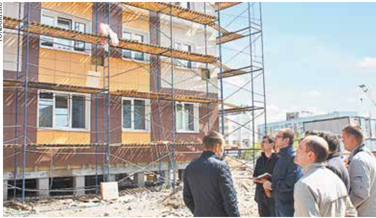
Во время проверки домов, строящихся для переселенцев в Северодвинске
