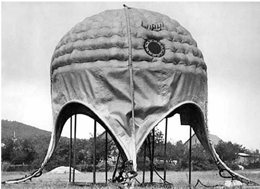
Пневматический подводный дом «Спрут»
