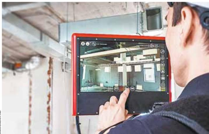
Платформа BRIO Mixed Reality System позволяет работать с цифровой моделью здания прямо на строительной площадке
