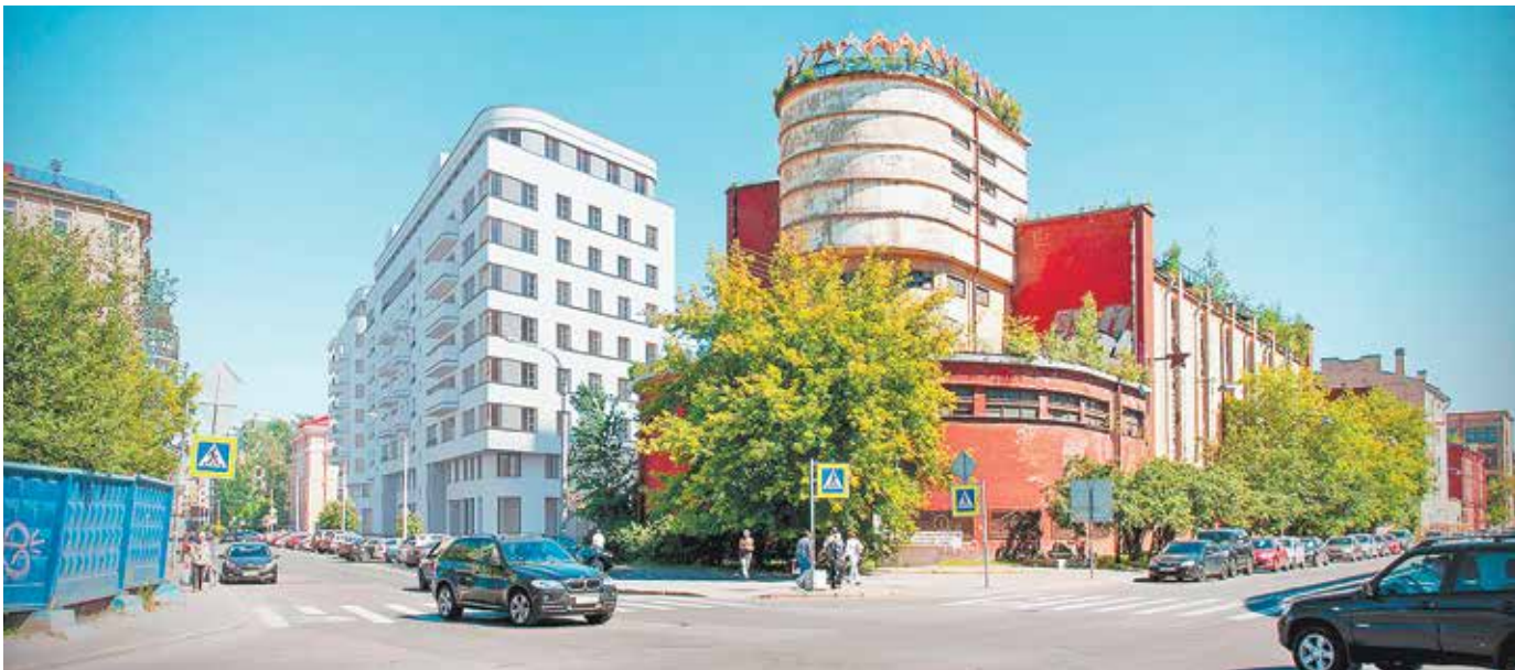
ЖК «Мендельсон» (слева) и конструктивистское здание силовой станции фабрики «Красное знамя»
