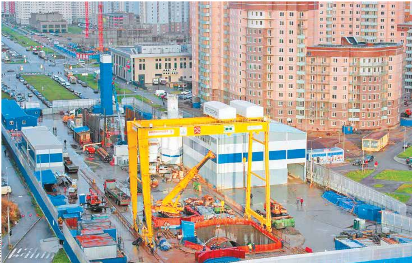
Стартовый котлован на Туристской улице
