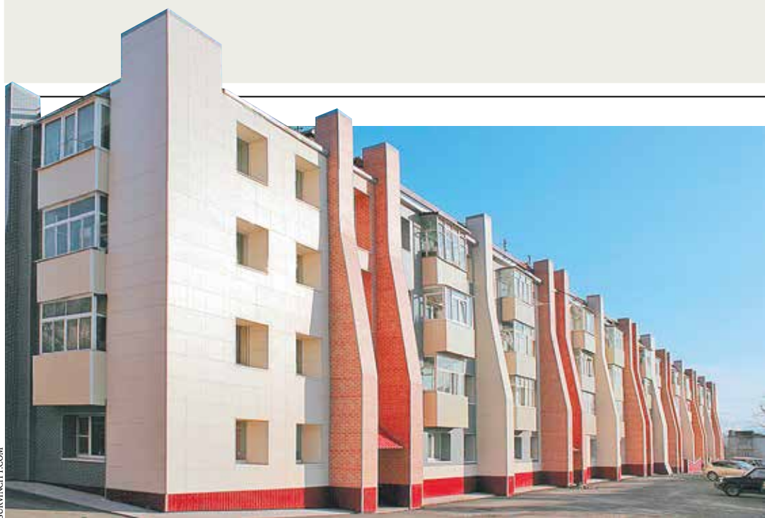
Жилой дом в Петропавловске-Камчатском, где было проведено сейсмоукрепление
