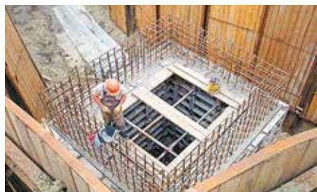
На строительстве коллектора «Разгуляевский»
