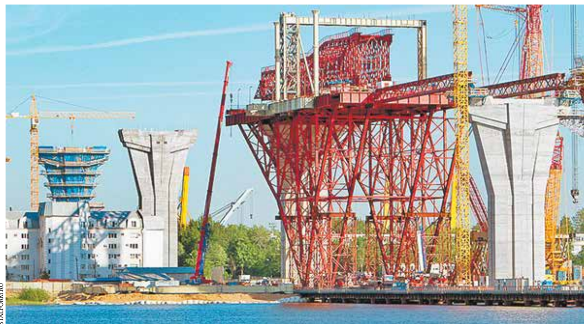
Надвижка пролетных строений двухуровневого моста через Морской канал
