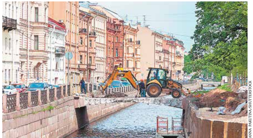
Ремонт моста на острове Новая Голландия в центре Санкт-Петербурга
