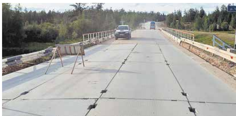
Автомобильная дорога общего пользования «Вилюй». Монтаж долговечного покрытия из железобетонных предварительно напряженных плит марок ПДН
