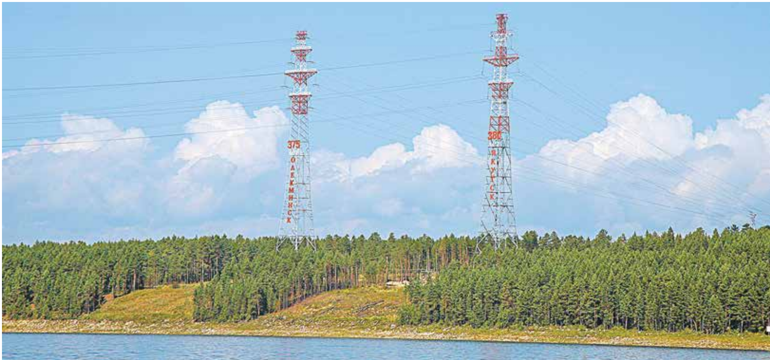
Воздушные переходы через реки Олекма и Лена с общей шириной надводной части 2323,5 метра
