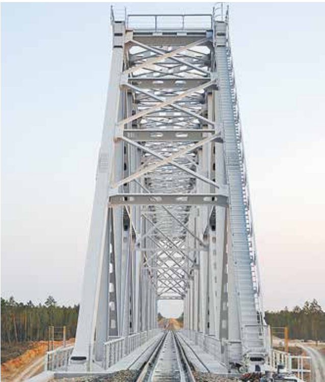
Внеклассный металлический мост через реку Менду на участке «Томмот—Якутск»
